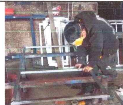
Foto 6: Puertas de servicios sanitarios
