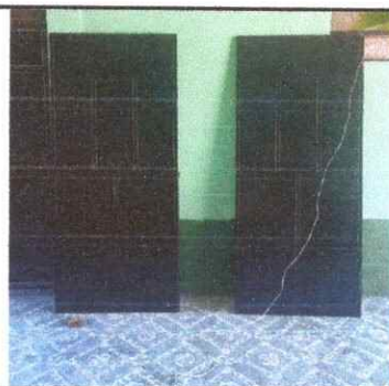
Foto 6: Puertas de servicios sanitarios
