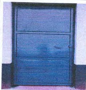
Foto 9: sustitución de puerta
