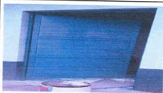
Foto 9: sustitución de puerta
