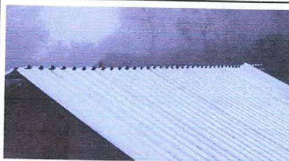
Foto 8: sustitución de elementos de fijación
