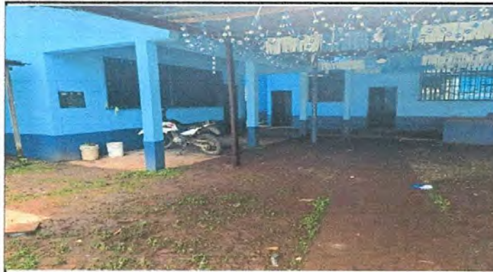
Foto 7: Finalización de Pintura en Paredes Exteriores
