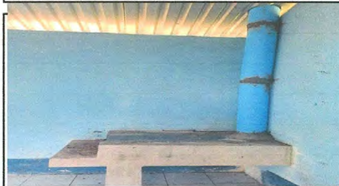
Foto 4: Finalización de plancha
