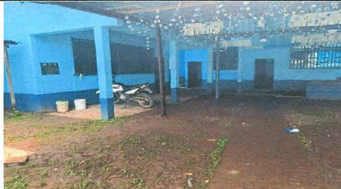
Foto 1: Finalización pintura completa en el centro Educativo
