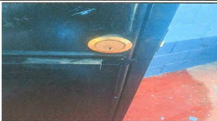
Foto 2: Finalización de 'pintado de puerta
