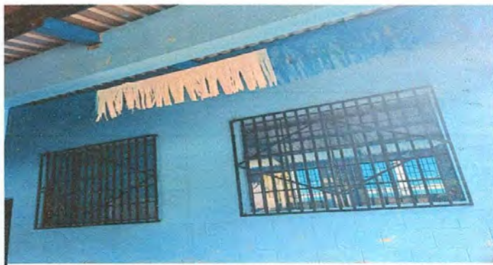
Foto 6: Finalización de balcones
