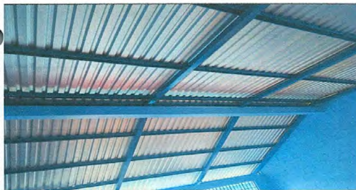
Foto 5: Finalización de techo parte inferior
