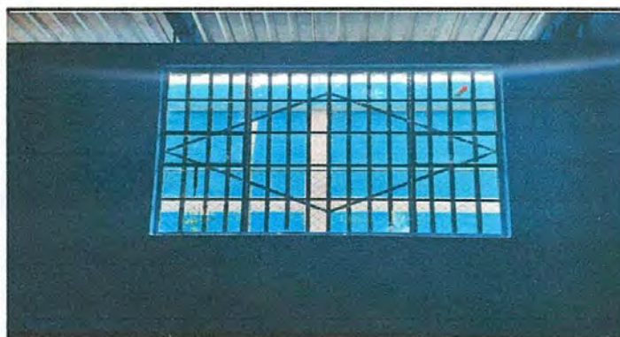
Foto 3: Finalizacion de Vidrios
