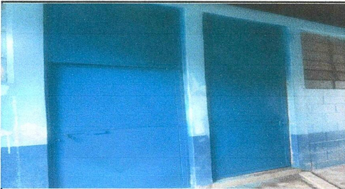
Foto 3: Sustitución de puertas entrada de baños finalizada
