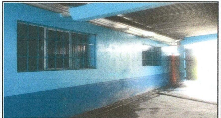
Foto 4: Sustitución de balcones y ventanas finalizada
