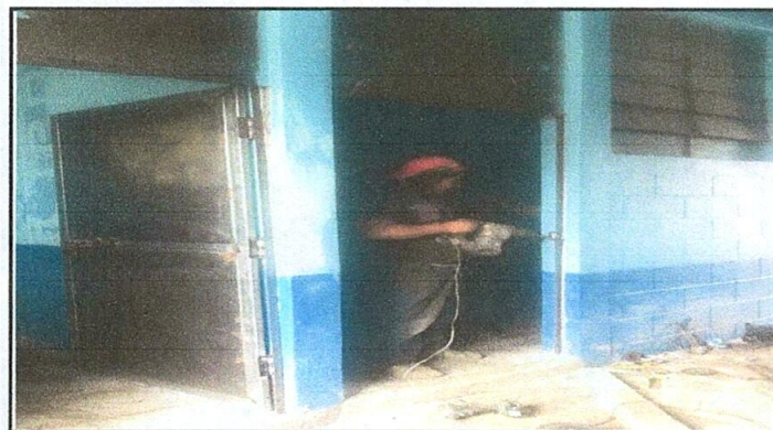
Foto 3: colocando las puertas en la entrada de los baños
