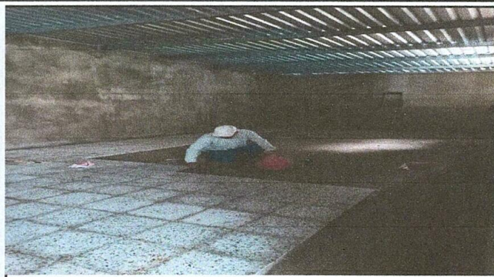
Foto 2: colocando los pisos en el aula
