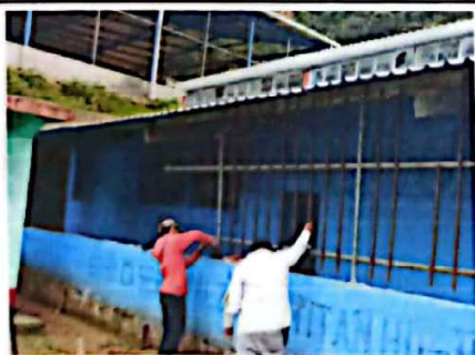
FOTO 5: CAMBIO DE BALCONES
