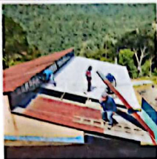
FOTO 1: CAMBIO DE TECHO
