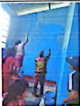
FOTO 7: APLICACIÓN DE PINTURA
