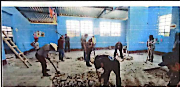
FOTO 3: CAMBIO DE PISO
