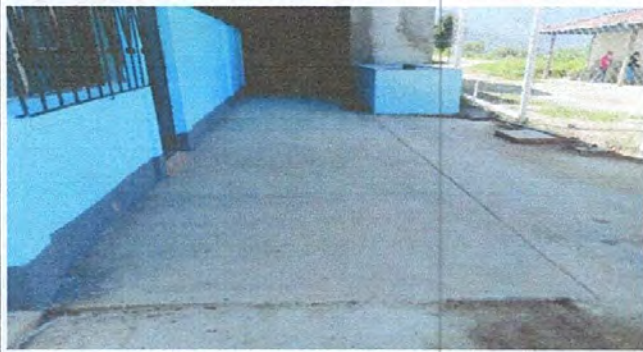
foto 7: reparación de plancha de concreto de patio en mal estado
