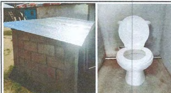
foto 5: SERVICIOS SANITARIOS Y SUS ACCESORIOS, sustitución de lamina, de inododoros a tazas lavables, contra llaves, llaves de compuerta
