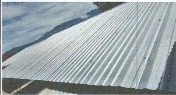
foto 1: Sustitución de lámina, por lámina troquelada aluzinc calibre 26, se filtra el agua y por dentro con pedazos de tabla y pegamento esta tapada
