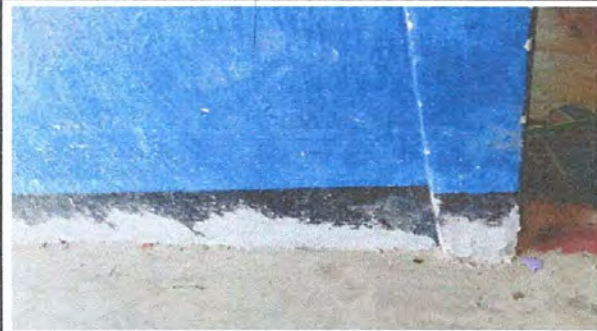
foto 10: Sellado de grietas y fisuras en la pared del aula en la parte de afuera
