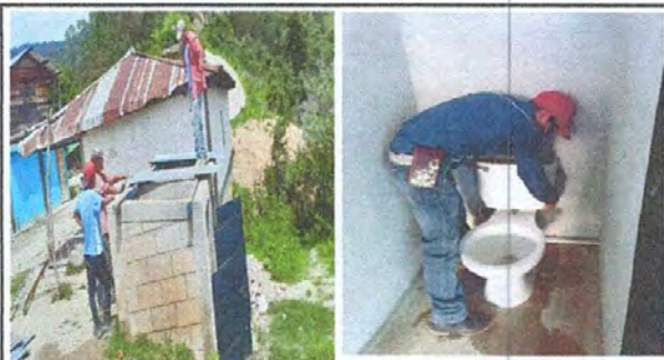
foto 5: SERVICIOS SANITARIOS Y SUS ACCESORIOS, sustitución de lamina, de inododros a tazas lavables, contra llaves, llaves de compuerta
