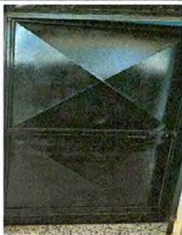
Foto 5: Puertas de metal nuevas
