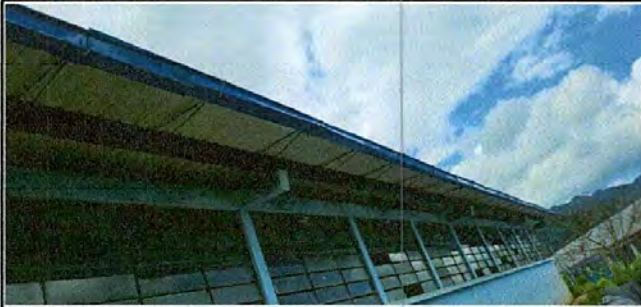
Foto 3: Canales de bajadas de agua instaladas
