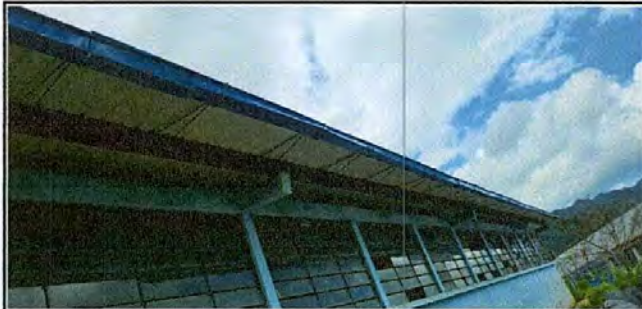
Foto 3: Canales de bajadas de agua instaladas
