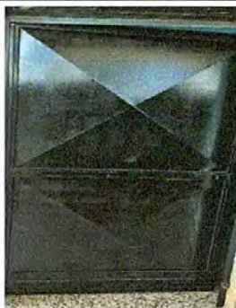
Foto 5: Puertas de metal nuevas
