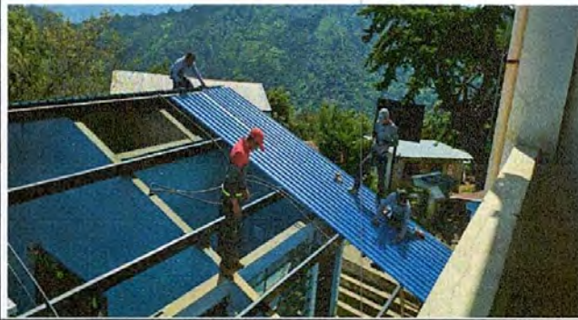
Foto1: Colocacion de lamina troquelada de Aluzinc
