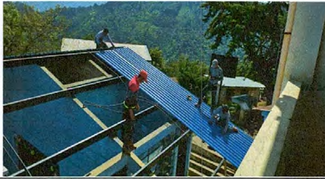
Foto1: Colocacion de lamina troquelada de Aluzinc
