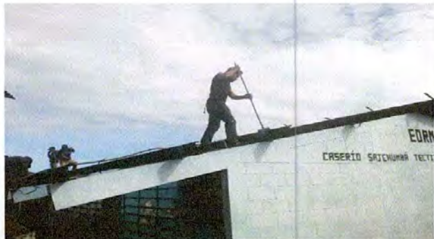
Foto 3: Mantenimiento de costaneras
