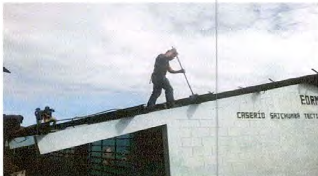
Foto 3: Mantenimiento de costaneras
