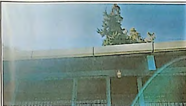
Foto 1: Mejoramiento de bajada de agua pluvial
