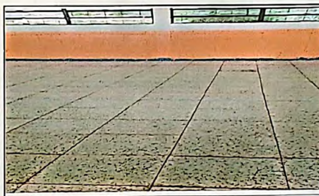
Foto 4: Sustitución de piso de cemento líquido por piso de granito
