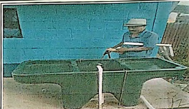
Foto 2: Sustitución de pila de concreto
