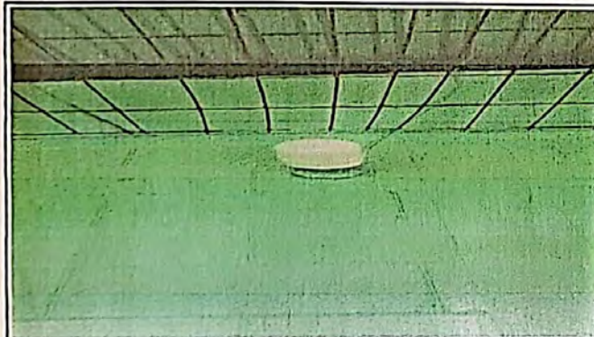
Foto 3: Sustitución de focos ahorradores
