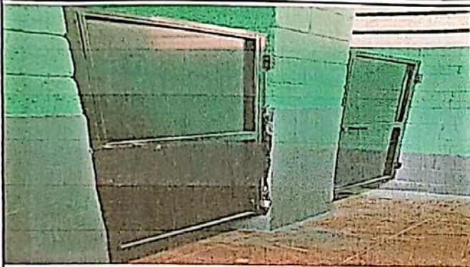
Foto 1: Mejoramiento de puerta de metal
