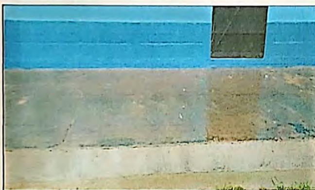
Foto 3: Mejoramiento de cuneta de concreto
