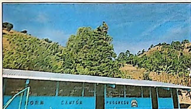
Foto 5: Sustitución de pintura de interiores y exteriores
