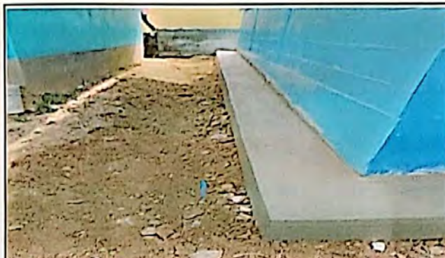
Foto 2: Sustitución de banqueta de concreto
