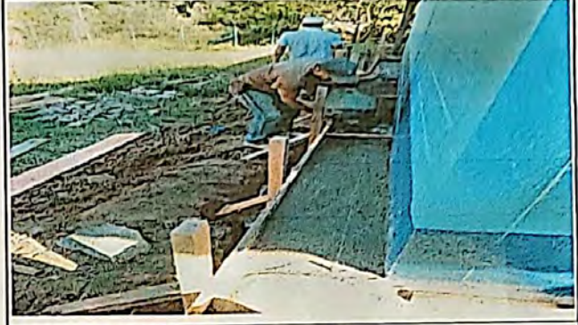
Foto 2: Sustitución de banqueta de concreto
