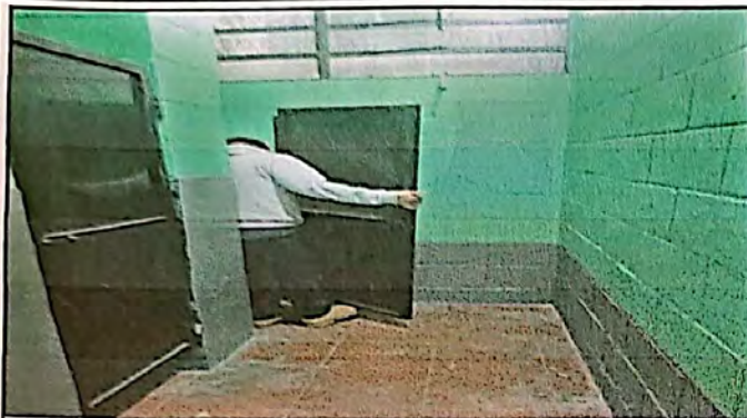
Foto 1: Mejoramiento de puerta de metal
