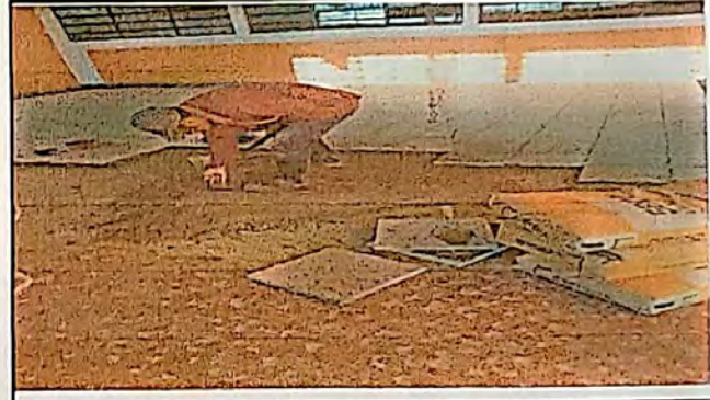
Foto 4: Sustitución de piso de cemento líquido por piso de granito
