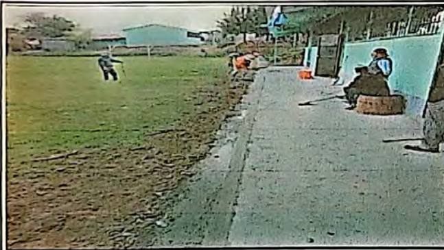
Foto 3: Mejoramiento de cuneta de concreto
