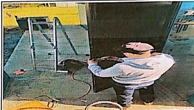
Foto 2: Sustitución de chapas
