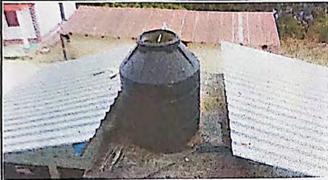
Foto 1: MEJORAMIENTO DE BOMBA DE AGUA
