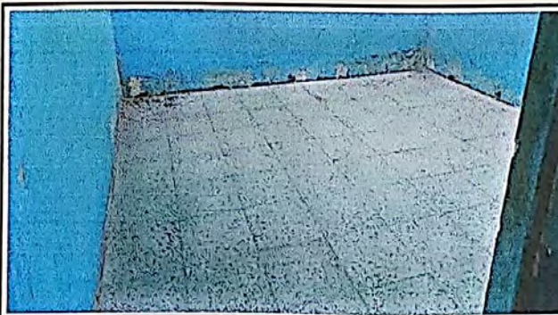
Foto 4: CAMBIO DE PISO DE CEMENTO POR PISO DE GRANITO
