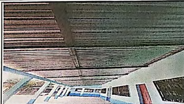
Foto 2: SUSTITUCIÓN DE CAMBIO DE MADERA POR METAL
