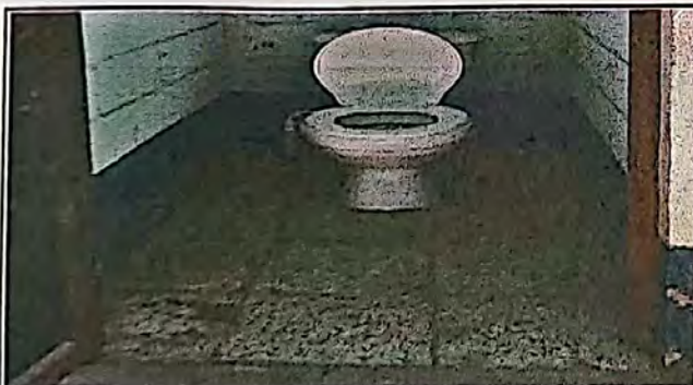
Foto 3: CAMBIO DE SANITARIOS
