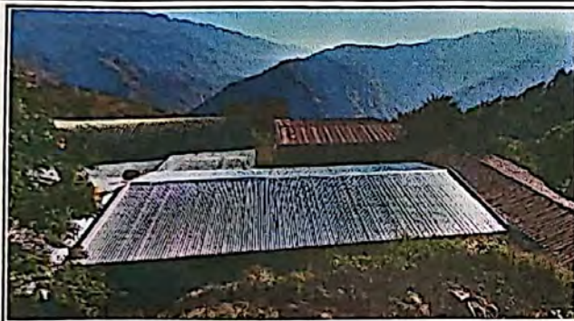
Foto 1: CAMBIO DE TECHO DE LAMINA
