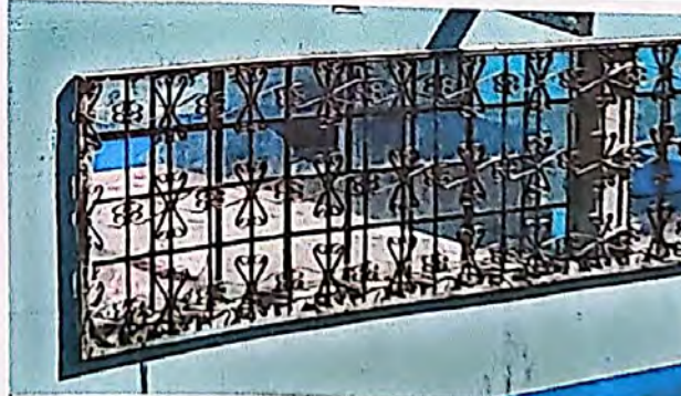
Foto 6: sustitucion de vidrios
