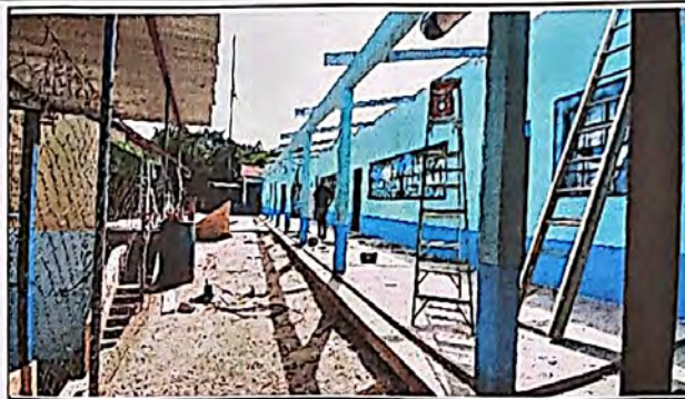
Foto 2: Sustitución de Costaneras
