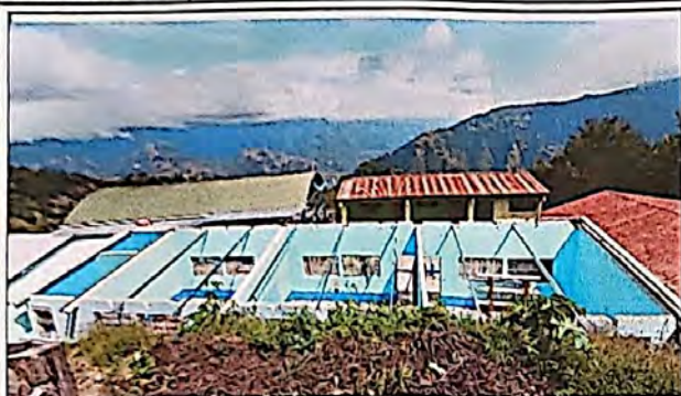
Foto 1: Mejoramiento de techo
