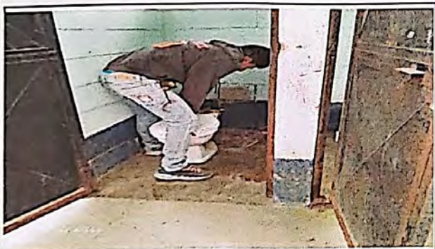
Foto 3: Sustitución de sanitarios
