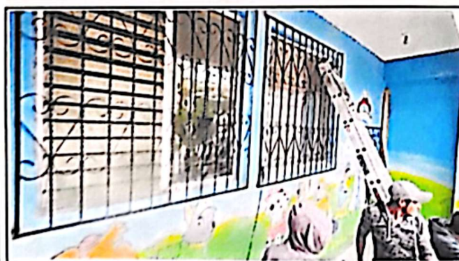
Vidrios y balcones sustituidos
