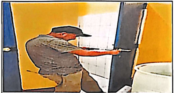
Sustitución de chapas en mal estado
