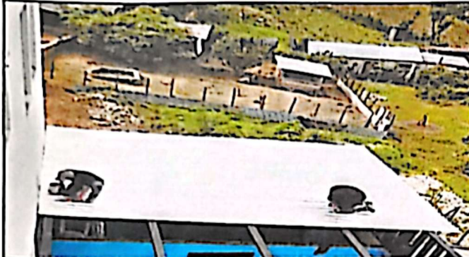
Proceso de cambio de techo
