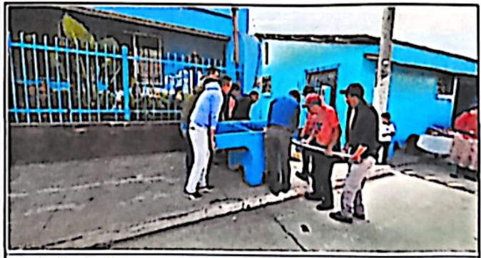
Instalación de pila
