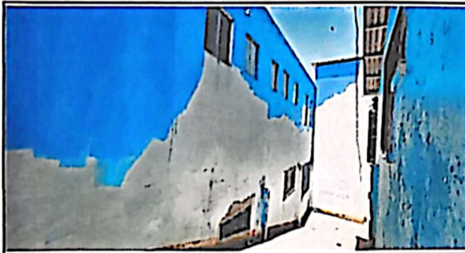
Pintura del establecimiento en proceso
