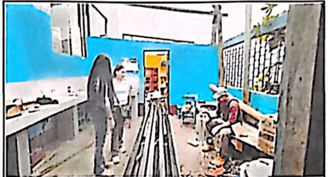
Sustitución de costaneras
