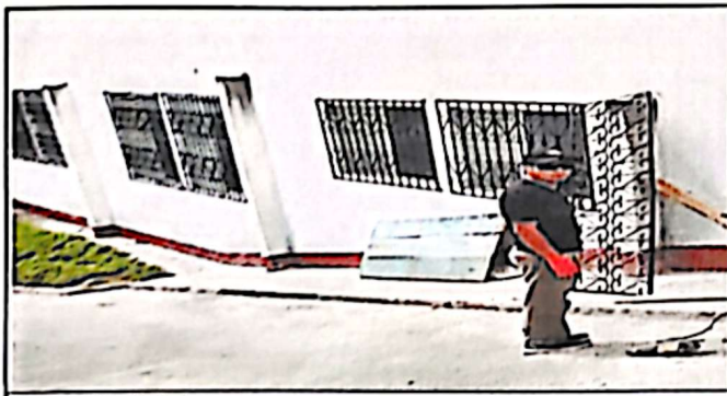
Sustitución de balcones
