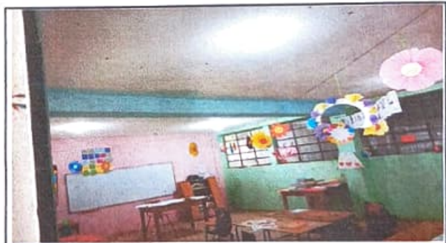
Foto 4: Situación de Reparación del Sistema Eléctrico.
