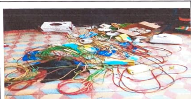
Foto 4: Situación de Reparación del Sistema Eléctrico.
