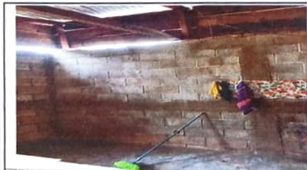
Foto 5. Situación de repello y cernido de paredes
