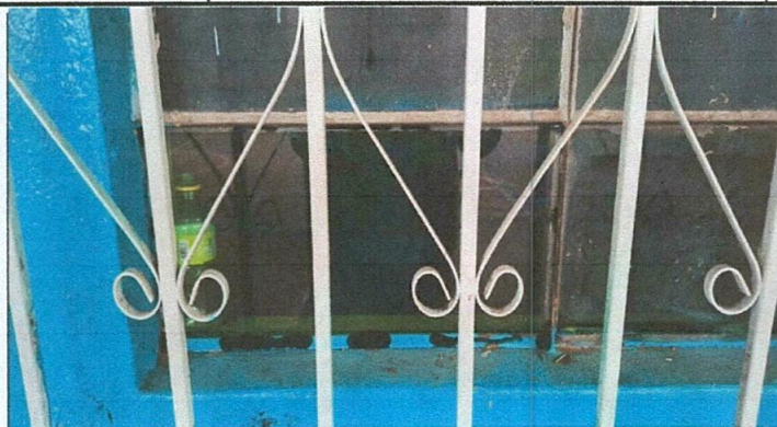
Reparacion de Vidrios
