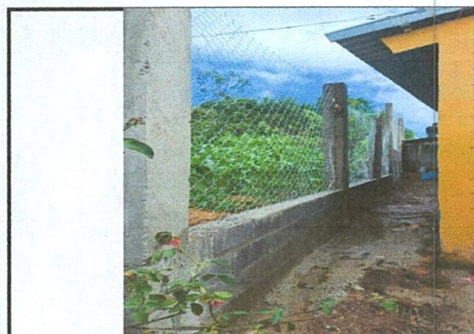
Reparacion de muro perimetral
