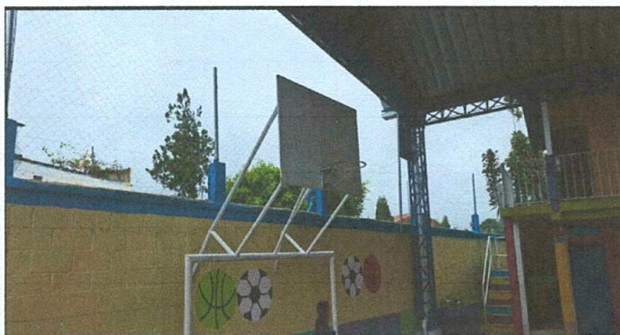
Reparación muro de contención
