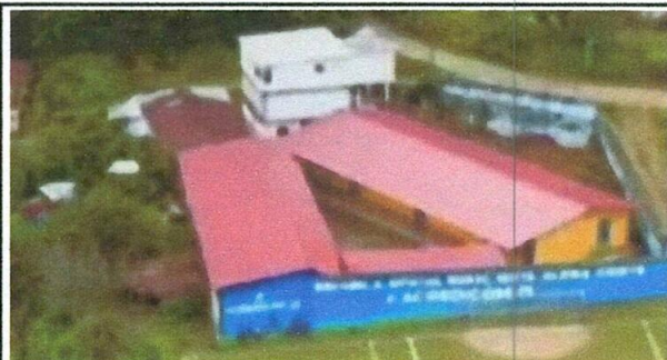
Foto 1. sustitucion de lamina por lamina troquelada
