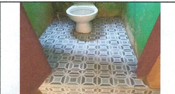
Foto 5. Sustitucion de piso de baño
