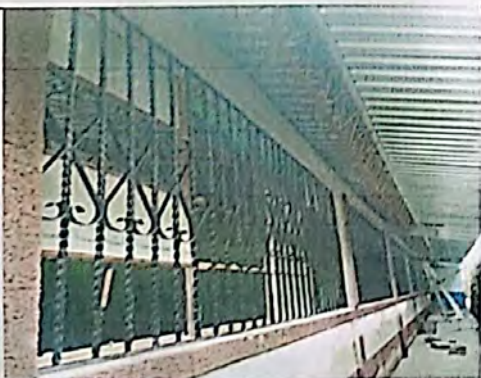
Foto 5: COLOCACIÓN DE BALCONES DE VENTANAS DE AULAS.
