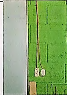
Foto 4: MANTENIMIENTO DE ENERGIA ELECTRICA
