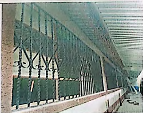
Foto 5: COLOCACIÓN DE BALCONES DE VENTANAS DE AULAS.
