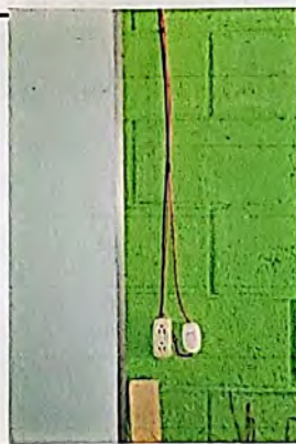
Foto 4: MANTENIMIENTO DE ENERGIA ELECTRICA
