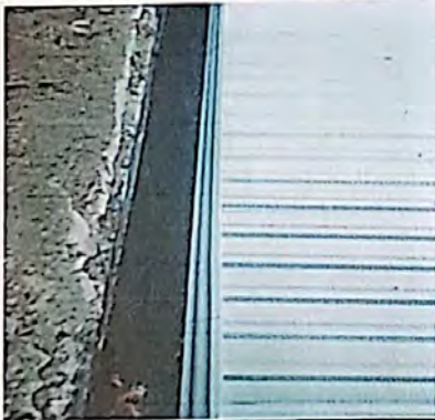
Foto 3: SUSTITUCIÓN DE CANAL AGUA PLUVIAL A CANAL CANOA CLÁSICA PVC AMANCO.
