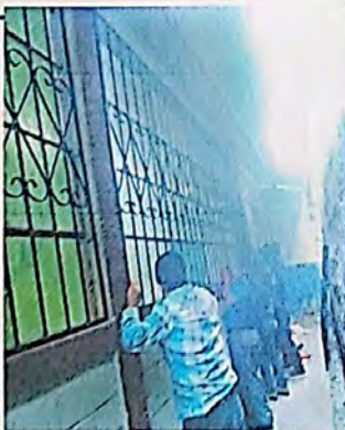
Foto 5: COLOCACIÓN DE BALCONES DE VENTANAS DE AULAS.
