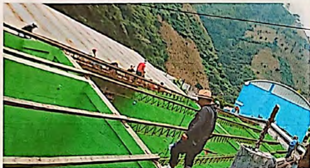
Foto 1: SUSTITUCIÓN DE LÁMINA, M POR LÁMINA TROQUELADA TR-101 CAL 26 ZINTROALUM
