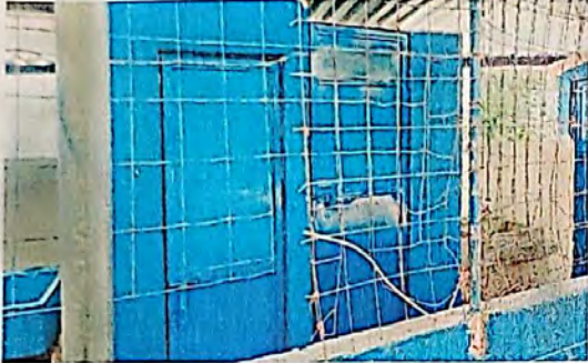
Foto1: Sustitución de puerta en servicios sanitarios
