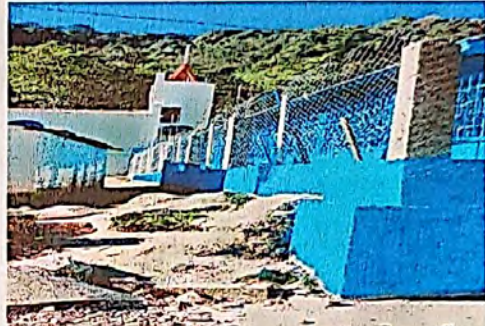
Foto 2: Sustitución de muro perimetral de block con tubo hg y malla galvanizada, soleras intermedias y columnas.
