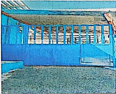
Foto1: Sustitución de portón de metal
