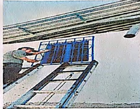
Foto 2: Sustitución de balcones de metal
