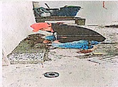
Foto 4: Sustitución de piso de concreto o granito
