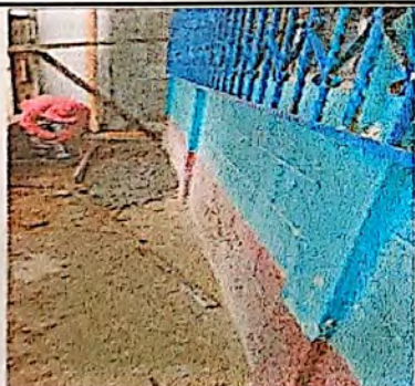
Foto 3: Sustitución de banquetas de concreto
