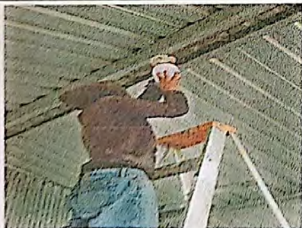
Foto 5: Sustitución de focos ahorradores
