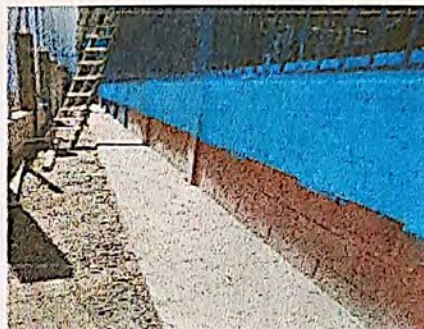
Foto 2: Sustitución de muro perimetral de block con tubo hg y malla galvanizada, soleras intermedias y columnas.
