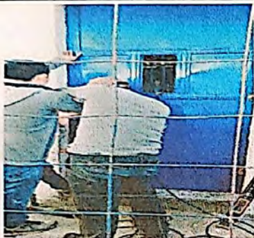
Foto1: Sustitución de puerta en servicios sanitarios
