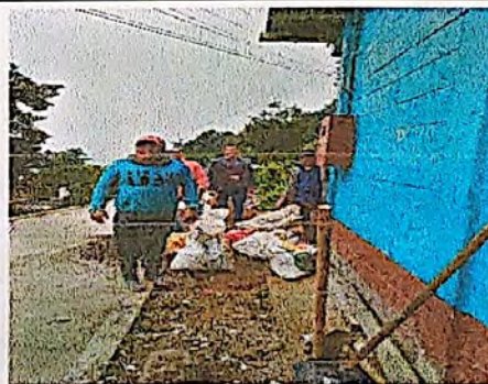
Foto 4: Sustitución de canal de pvc
