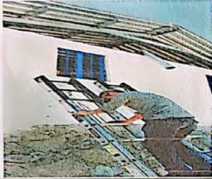
Foto1: Sustitución de ventanas de madera por metal mas vidrio
