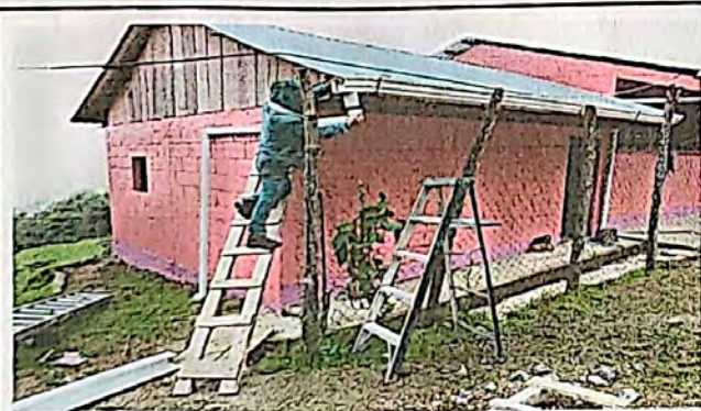
Foto 9: coloando bajadas de agua
