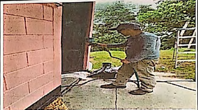
Foto 8: mantenimiento de puertas
