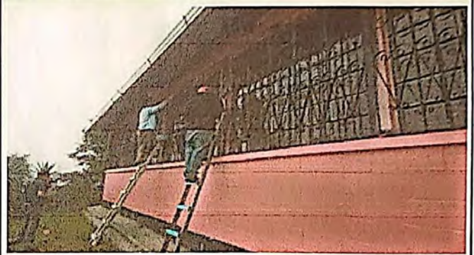
Foto 2: pintura de muros exteriores e interiores
