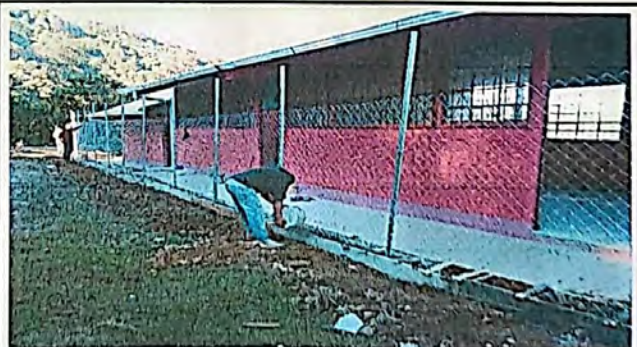
Foto 6: colocando tubo y maya
