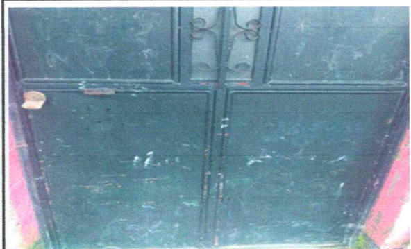
Foto 8: mantenimiento de puertas
