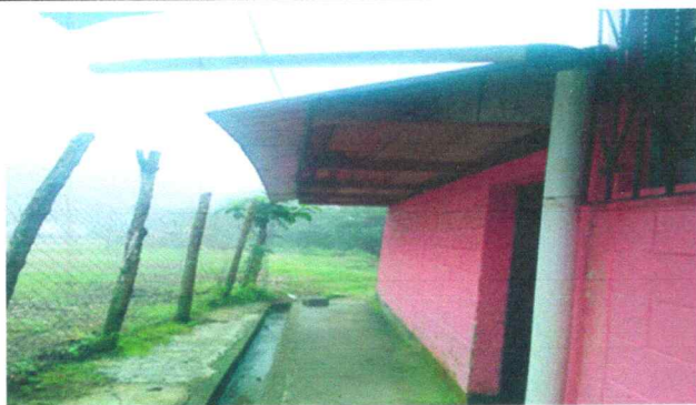
Foto 9: sustituir bajadas de agua
