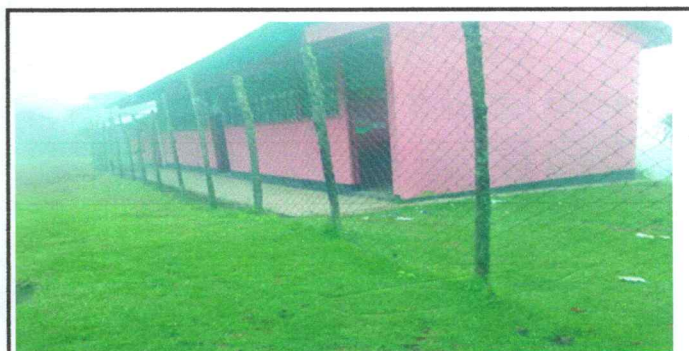
Foto 6: sustitución de tubo y maya
