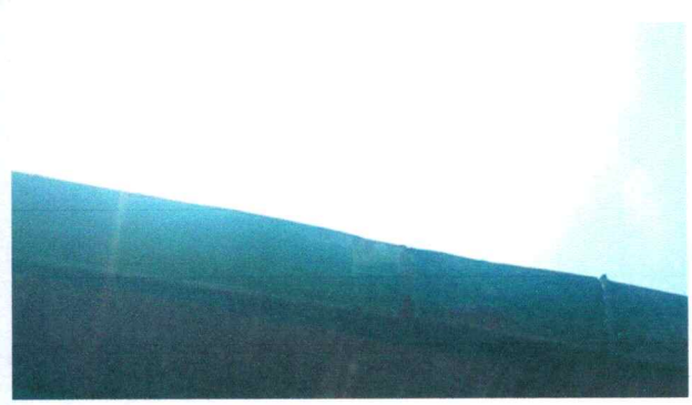
Foto 10: sustitución de canales
