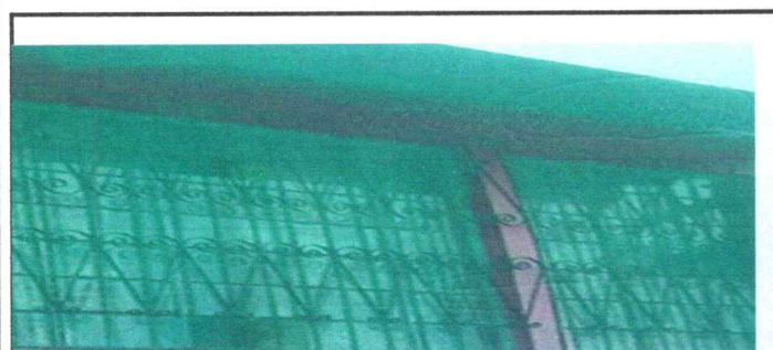
Foto 5: sustitución de balcones
