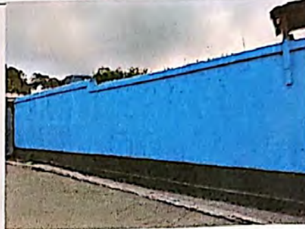
FOTO No. 2 PINTURA MUROS EXTERIORES
