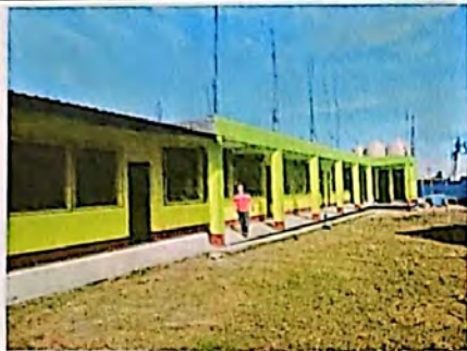
FOTO No. 1 PINTURA PARED
