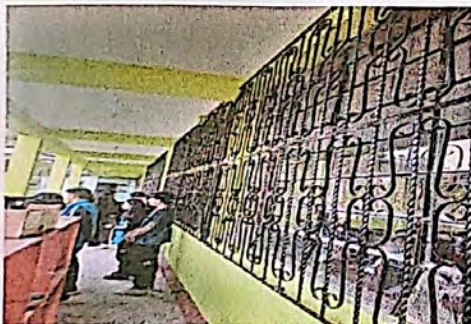
FOTO No. 9 BALCONES Y VIDRIOS
