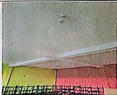
FOTO No. 5 FOCO ELECTRICO
