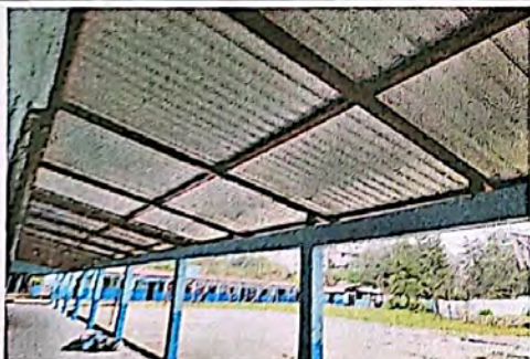
FOTO No. 11 TECHO AULA 2
