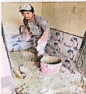
FOTO No. 5 MANTENIMIENTO DE BAÑO
