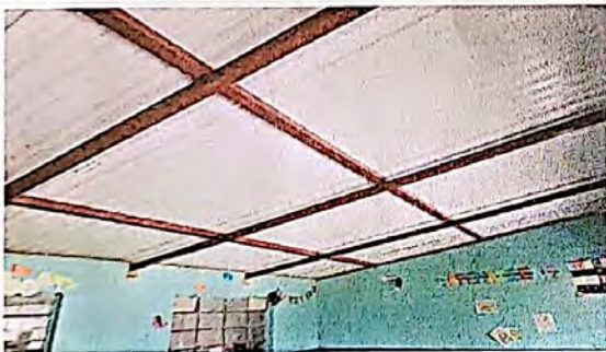
FOTO No. 3 TRABAJO DE ESTRUCTURA
