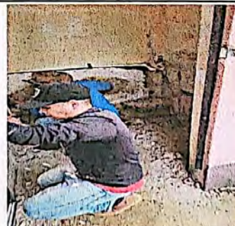
FOTO No. 6 MANTENIMIENTO DE BAÑO
