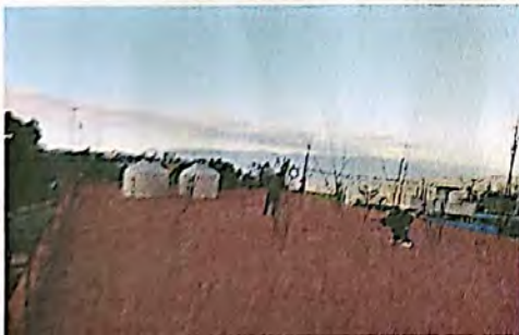
FOTO No. 11 IMPERMIABILIZACIÓN
