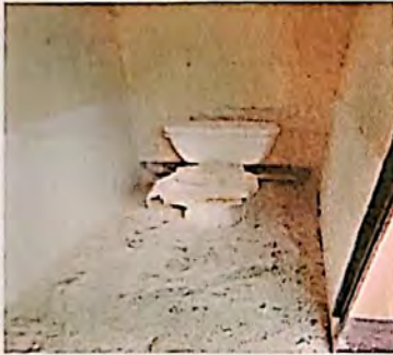
FOTO No. 7 CAMBIO DE TAZAS DE BAÑO
