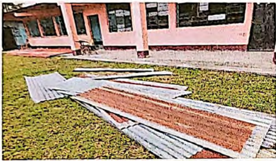
FOTO No. 1 CAMBIO DE LÁMINA
