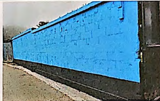
FOTO No. 8 PINTURA DE PUERTAS Y PORTONES
