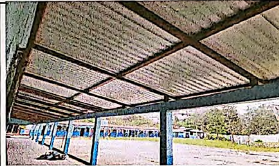
FOTO No. 2 CAMBIO DE LÁMINA
