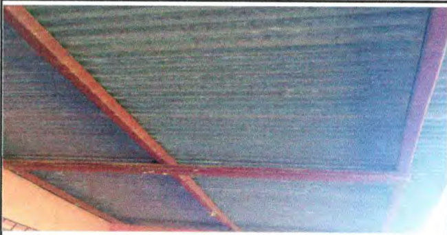
FOTO 9. SUSTITUCION DE LAMINA ACANALADA POR LÁMINA TROQUELADA
