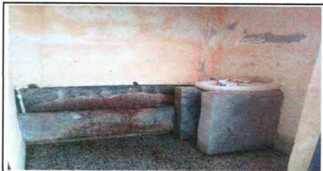
FOTO 5. DIGITOTIO EN MAL ESTADO
