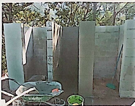
instalacion de nuevos inodoros
