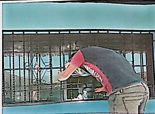
instalando proteccion de ventanas.
