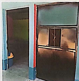
mejoria e instalacion de puertas de metal.
