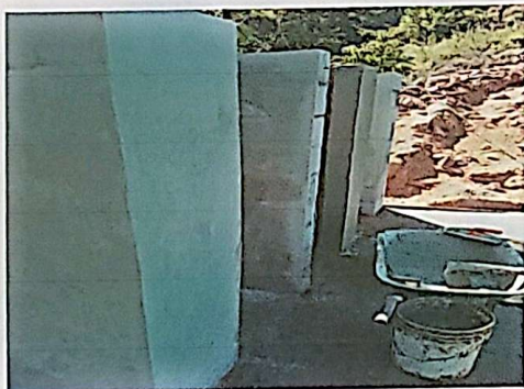
servicios sanitarios en remodelacion
