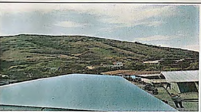
Foto 5: Sustitución de lámina por lámina troquelada aluzinc
