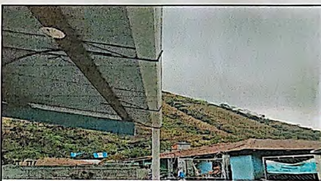
Foto 6: Mejoramiento de bajada de agua pluvial
