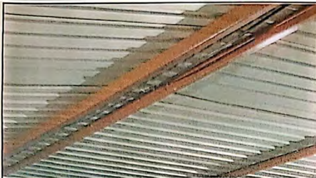
Foto 1: Sustitución de cableado eléctrico
