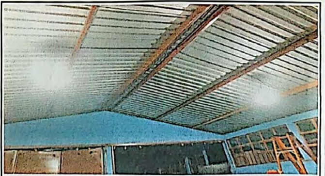
Foto 6: Sustitución de focos ahorradores
