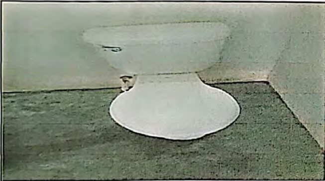
Foto 3: Sustitución de inodoro
