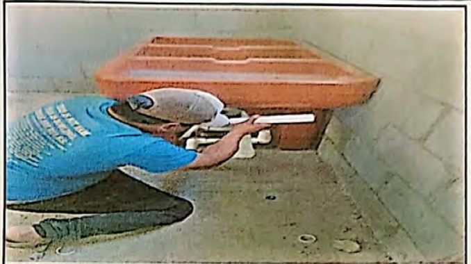
Foto 2: Sustitución de pila de cemento
