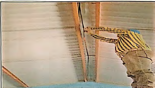
Foto 1: Sustitución de cableado eléctrico
