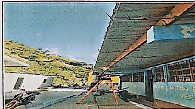
Foto 6: Mejoramiento de bajada de agua pluvial
