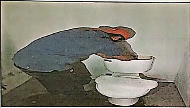
Foto 3: Sustitución de inodoro
