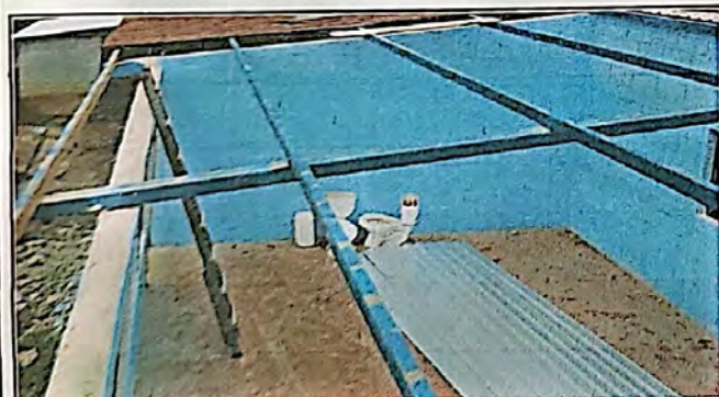
Foto 5: Sustitución de lámina por lámina troquelada aluzinc
