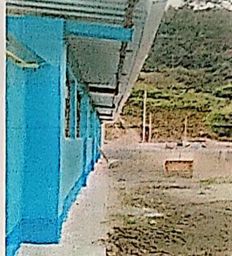
Foto 2: Los canales y las bajadas de agua pluvial se conectaron al techado para proteger de la humedad y posibles daños en las columnas y paredes del establecimiento educativo.
