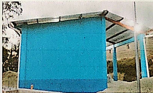
Foto 4: Los muros exteriores lucen mejor con su respectiva pintura cuidando el edificio escolar y sus alrededores.
