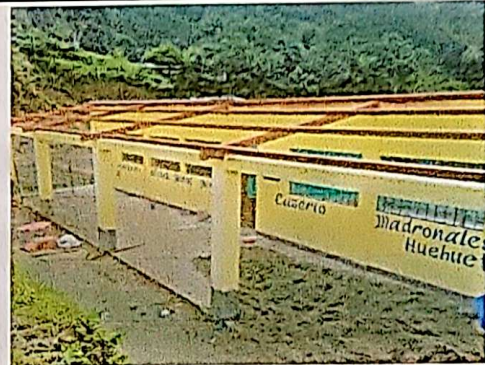
Foto 2: El techado se descubrió para realizar el reemplazo y la fijación de lámina troquelada en la estructura de metal.
