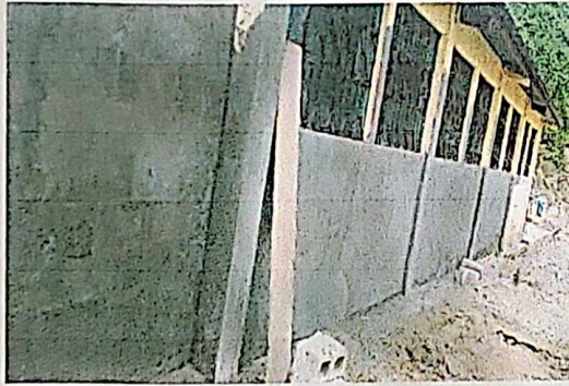
Foto 3: Las paredes se repellaron y prepararon los ambientes destinados para pintar de forma adecuada.
