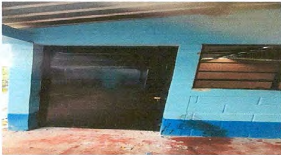
Foto1: Puertas nuevas instaladas
