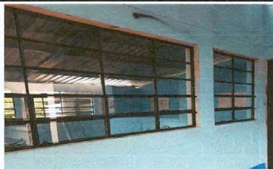
Foto 4: sustitución de ventanas terminado
