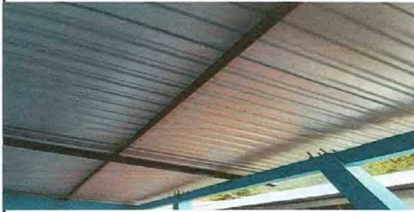
Foto 7: lijado y pintado de estructura de soporte de metal terminado
