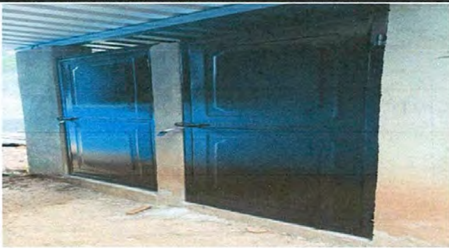
Foto 3: sustitución de puertas en baños intalado
