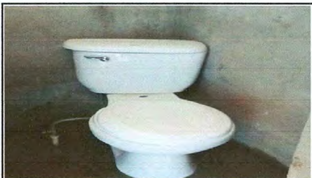
Foto 6: Inodoros nuevos instalados
