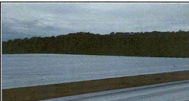
Foto 5: láminas nueva instalada
