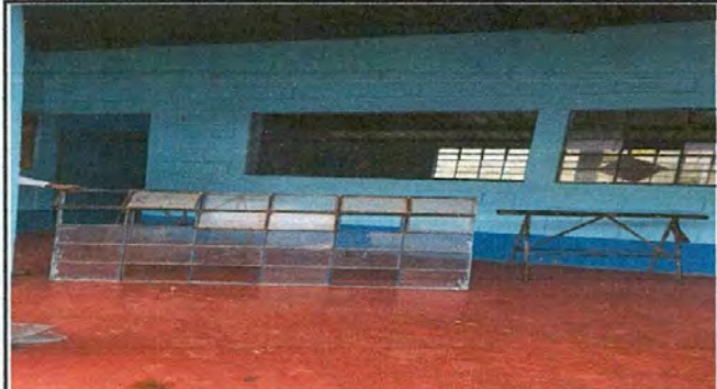
Foto 4: Quitando ventanas deterioradas
