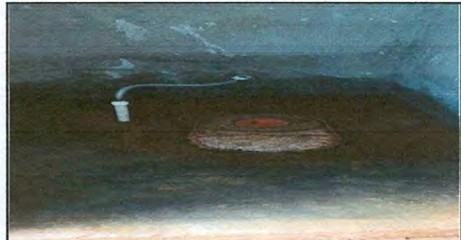
Foto 6: Se quito inodoro en mal estado para realizar el cambio
