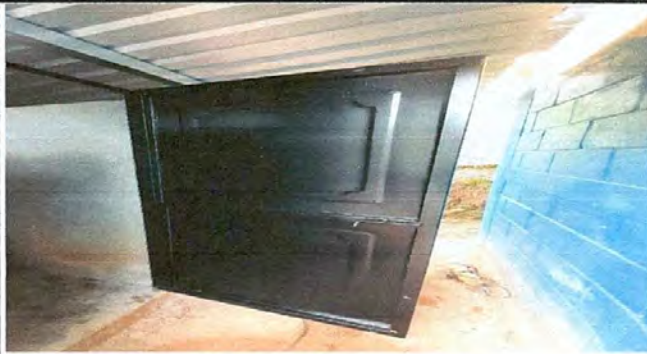
Foto 3: sustituyendo puerta en baños
