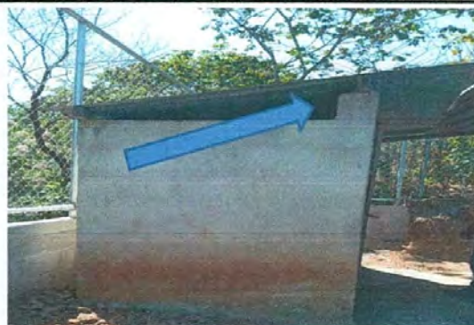
Foto 2: Sustrucción de estructura de soporte de madera por metal en los baños
