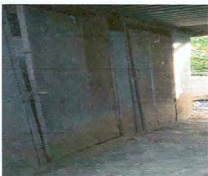
Foto 3: Sustrucción de puerta en servicios sanitarios por estar en mal estado
