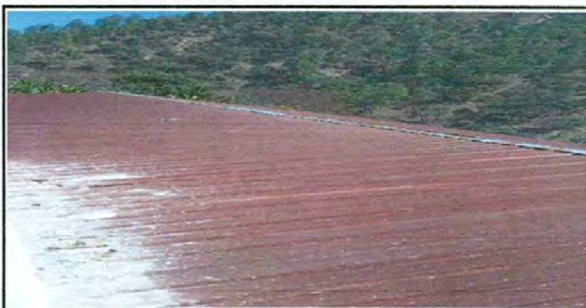
Foto 5: sustitución de láminas ya se cuele el agua en tiempo de invierno y capote ya estan viejas.
