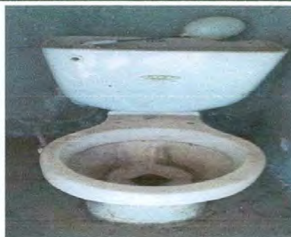
Foto 6: Sustrucción de inodoro por estar en mal estado.
