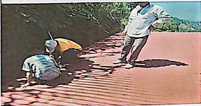
Foto1: SUSTITUCION DE LAMINA TROQUELADA CALIBRE 26
