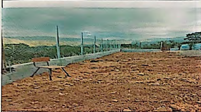
Foto 1: REPARACION DE MURO PERIMETRAL DE BLOCK CON TUBO HG Y MALLA GALVANIZADA SOLERAS INTERMEDIAS Y COLUMNAS DE 39MTS DE LARGO X 4MTS DE ALTO
