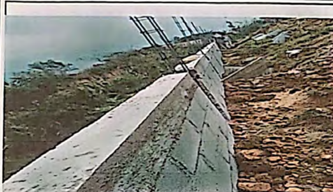
Foto 1: REPARACION DE MURO PERIMETRAL DE BLOCK CON TUBO HG Y MALLA GALVANIZADA SOLERAS INTERMEDIAS Y COLUMNAS DE 39MTS DE LARGO X 4MTS DE ALTO
