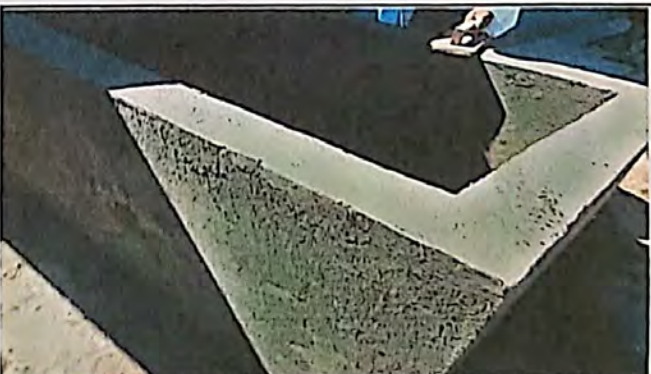
Foto 6: SUSTITUCION DE PILA DE CEMENTO DE 2 LAVADEROS DE 2MTSX60CMS
