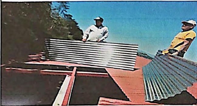
Foto 1: SUSTITUCION DE LAMINA TROQUELADA CALIBRE 26
