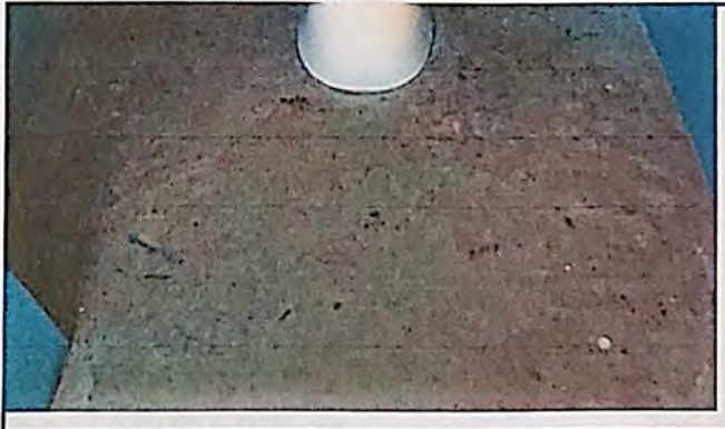
Foto 4: SUSTITUCION DE INODORO
