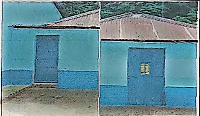
Foto 4: Sustrución de Puertas de Madera a Metal en Direcccion y Bodega
