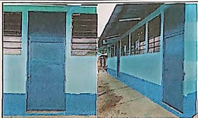
Foto 2: Sustitución de puertas en 4 aulas
