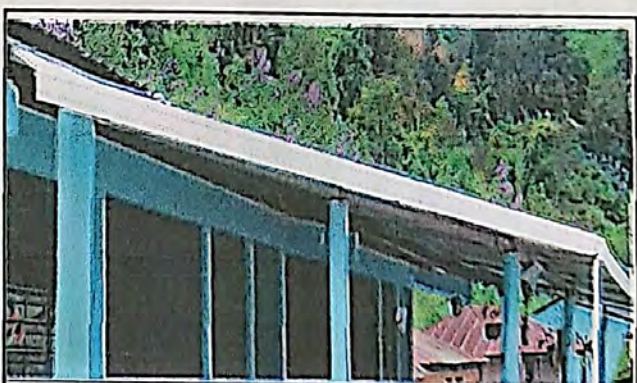
Foto 6: Instalacion de canales y bajantes de aguas fluviales
