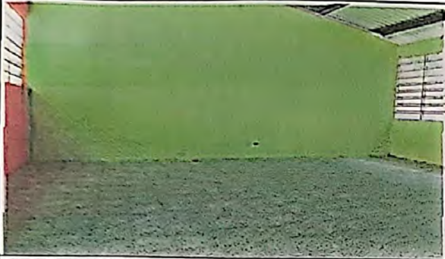
Foto 1: Reparación de piso de cemento liquido en dos Aulas
