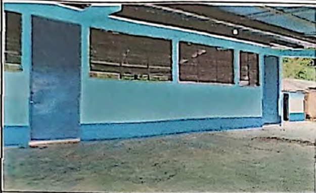
Foto 1: Sustitución de puertas en 4 aulas
