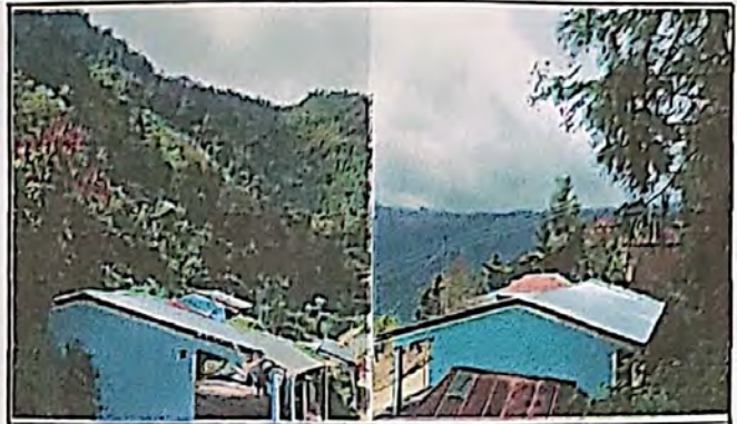
Foto 2: Sustrución de lámina, por lámina troquelada aluzinc calibre 26 en 2 aulas
