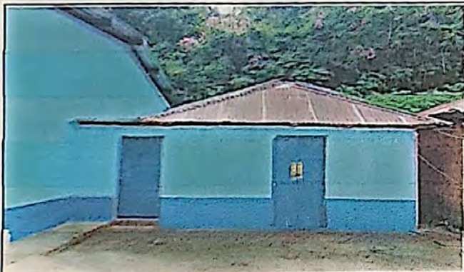
Foto 3: Sustrución de Puertas de Madera a Metal en Direcccion y Bodega
