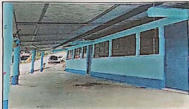
Foto 4: Reparación de planchas de concreto de patio
