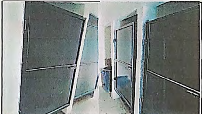
Foto 6: Sustrución de Puertas de Madera a Metal en baño
