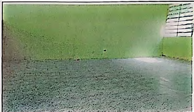
Foto 2: Reparación de piso de cemento liquido en dos Aulas y Corredor
