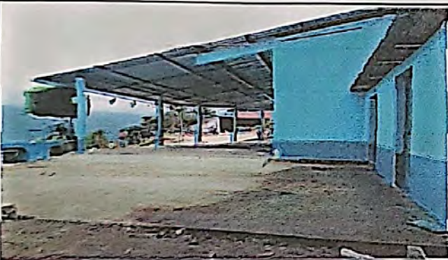
Foto 3: Reparación de planchas de concreto de patio
