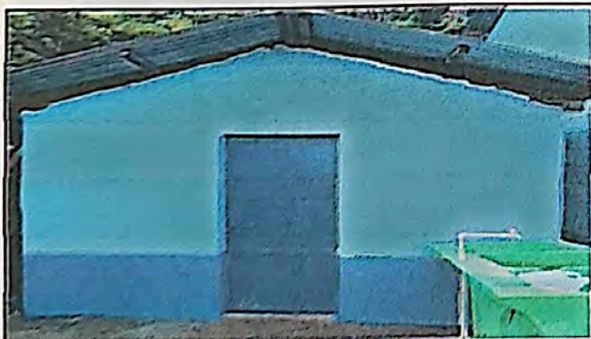
Foto 5: Sustrución de Puertas de Madera a Metal en Cocina.
