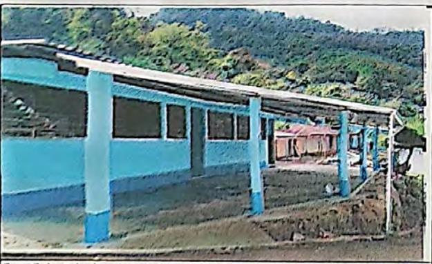
Foto 5: Instalacion de canales y bajantes de aguas fluviales
