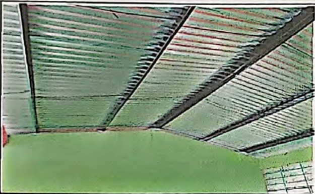
Foto 3: Pintura de costaneras de dos aulas
