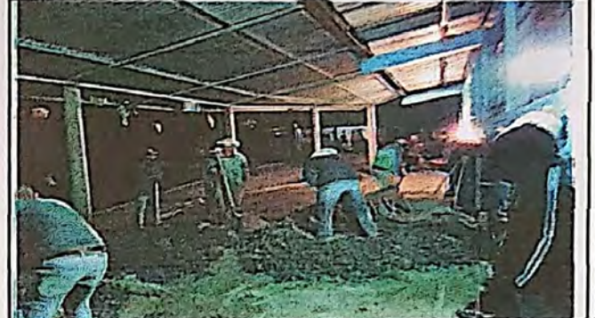
Foto 4: Reparación de planchas de concreto de patio
