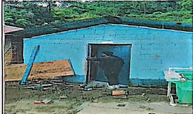
Foto 6: Sustrución de Puertas de Madera a Metal en Cocina.
