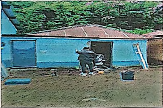
Foto 3: Sustrución de Puertas de Madera a Metal en Direcccion y Bodega
