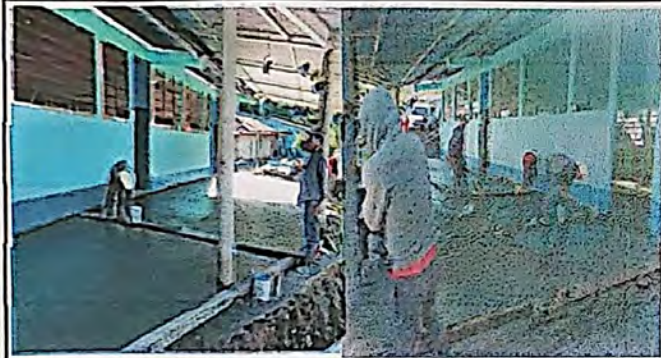
Foto 3: Reparación de planchas de concreto de patio
