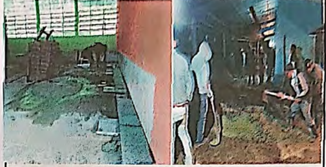
Foto 2: Reparación de piso de cemento liquido en dos Aulas y Corredor
