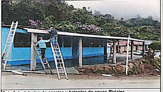
Foto 6: Instalación de canales y bajantes de aguas fluviales
