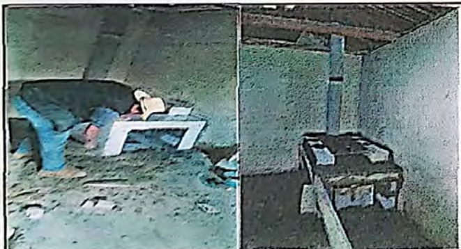
Foto 5: Sustitución de estufa rural (completa) incluye chimenea y plancha de metal
