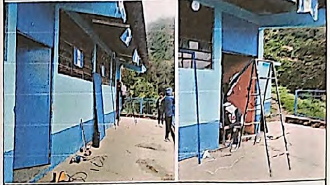
Foto 2: Sustitución de puertas en 4 aulas
