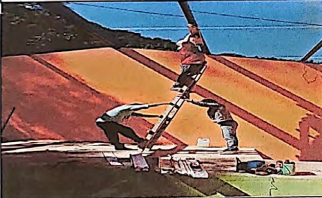
Foto 3: Pintura de costaneras de dos aulas
