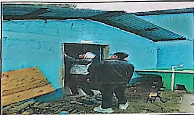
Foto 5: Sustrución de Puertas de Madera a Metal en Cocina.
