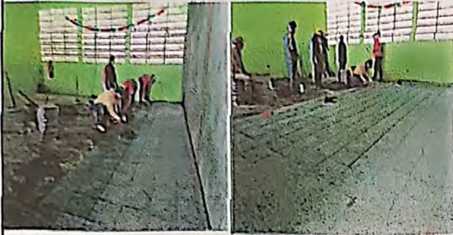
Foto1: Reparación de piso de cemento liquido en dos Aulas
