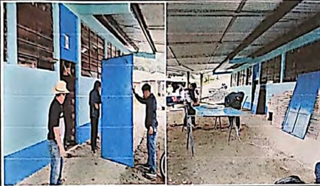
Foto 1: Sustitución de puertas en 4 aulas
