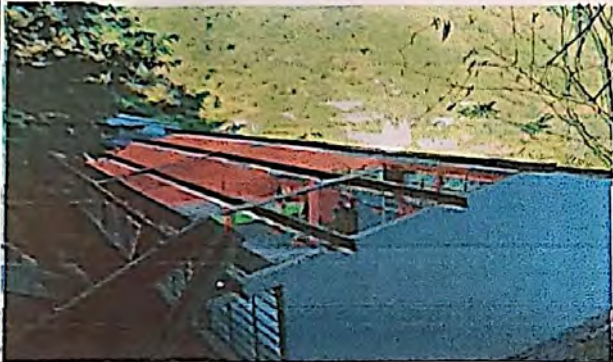
Foto 1: Sustrución de lámina, por lámina troquelada aluzinc calibre 26 en 2 aulas
