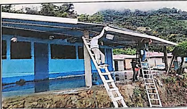
Foto 5: Instalación de canales y bajantes de aguas fluviales
