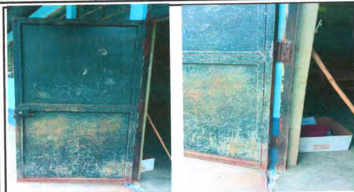
Foto1: Sustrucción de puertas en 4 aulas
