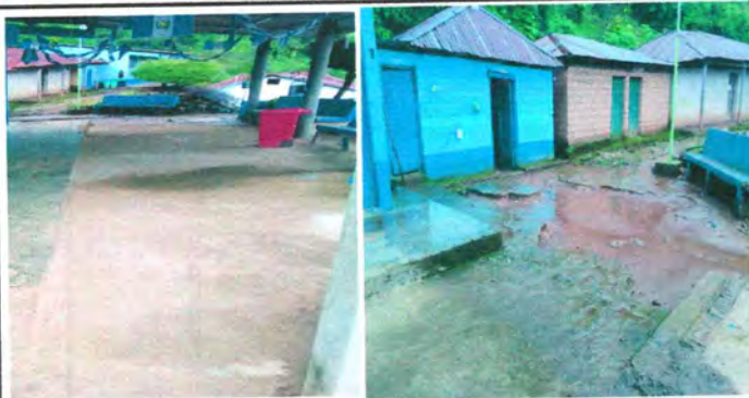
Foto 3: Reparación de planchas de concreto de patio
