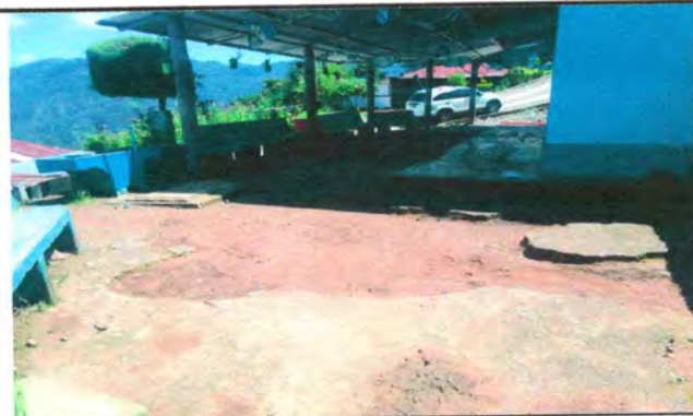
Foto 4: Reparación de planchas de concreto de patio
