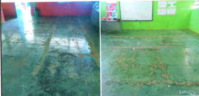
Foto 1: Reparación de piso de cemento líquido en dos Aulas y Corredor
