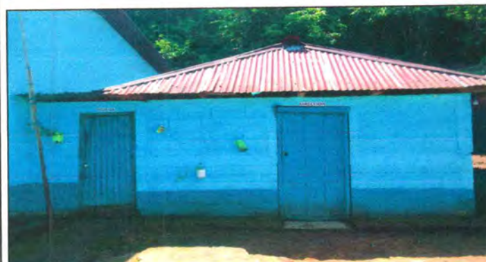
Foto 3: Sustitución de Puertas de Madera a Metal en Dirección y Bodega
