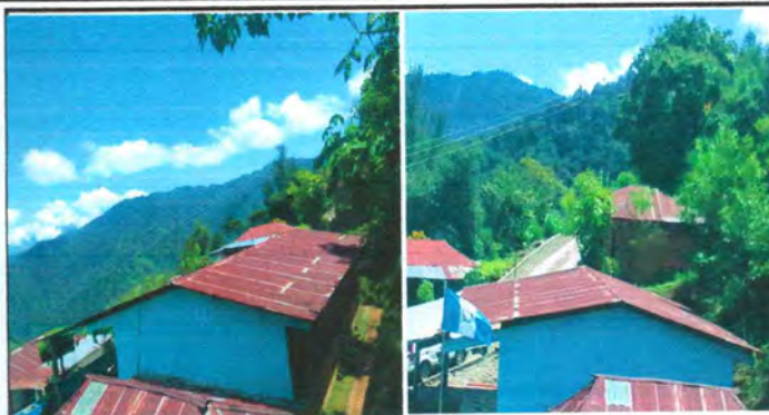
Foto 2: Sustitución de lámina, por lámina troquelada aluzinc calibre 26 en 2 aulas
