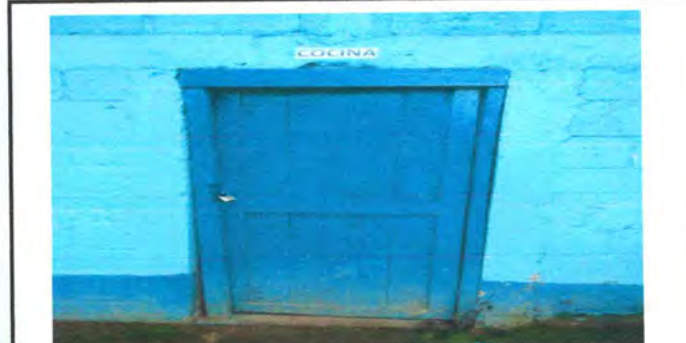
Foto 6: Sustitución de Puertas de Madera a Metal en Cocina.
