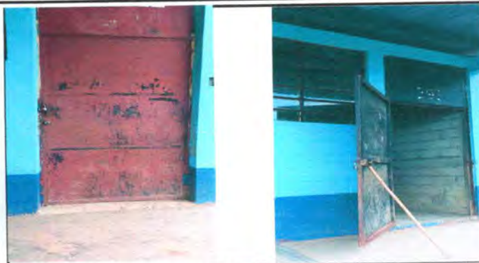
Foto 2: Sustrucción de puertas en 4 aulas
