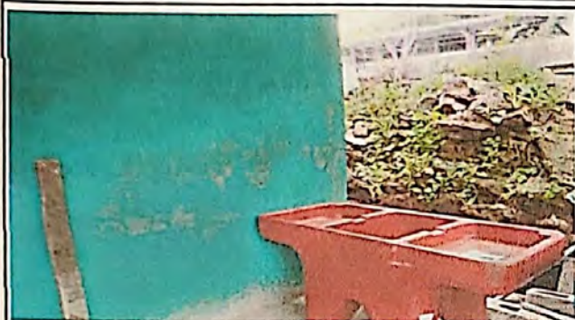
Foto1: SUTTITUCION DE PILA PLASTICA DE DOS LAVADEROS.
