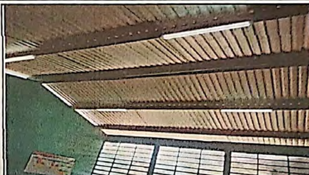
Foto 2: REPARACION DE CABLEADO ELECTRICO EN TRES AULAS.
