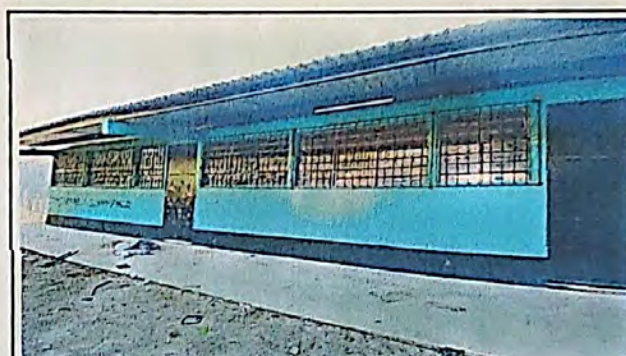
Foto 4: BALCONES DE METAL EN LA PARTE DE ENFRENTA DE LA ESCUELA PORQUE SE QUIEBRAN LOS VIDRIOS CUANDO LOS NIÑOS JUEGAN PELOTA
