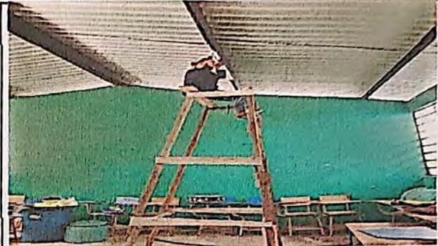
Foto 2: REPARACION DE CABLEADO ELECTRICO EN TRES AULAS.
