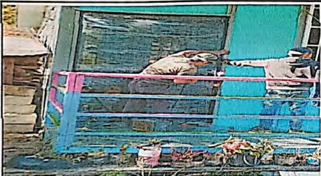
Foto 3: SISTITUCION DE PUERTA DE METAL EN EL AULA DE PÁRVULOS
