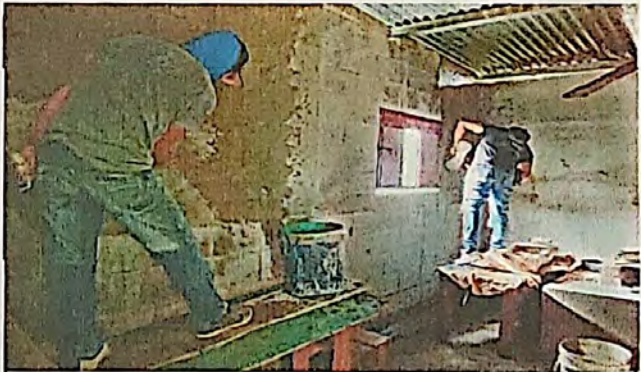
Foto 4: APLICACION DE REPELLO EN LA COCINA DE LA ESCUELA.
