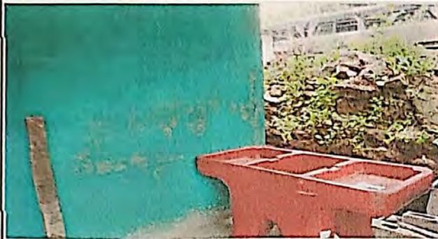
Foto1: SUTTITUCION DE PILA PLASTICA DE DOS LAVADEROS.
