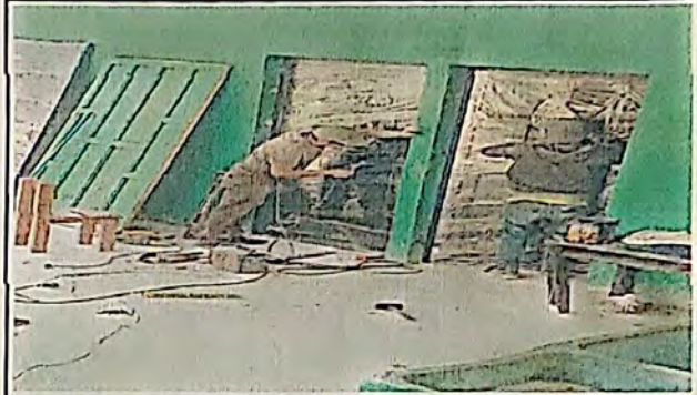
Foto 2: SUSTITUCION DE PUERTA DE BODEGA DE LA COCINA, PORQUE LA QUE TIENE ERA DE OTRA PUERTA Y NO CUBRE EL ESPACIO.
