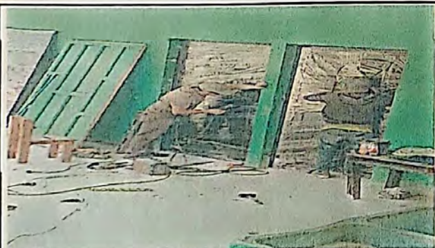
Foto 3: SUSTITUCION DE PUERTA DE MADERA DE LA COCINA POR PUERTA DE METAL.
