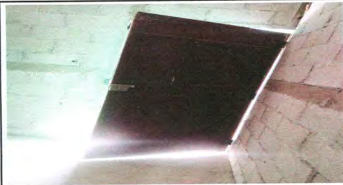
Foto 2: SUSTITUCION DE PUERTA DE BODEGA DE LA COCINA, PORQUE LA QUE TIENE ERA DE OTRA PUERTA Y NO CUBRE EL ESPACIO.
