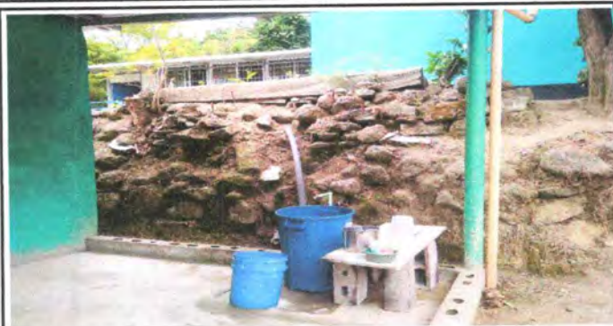
Foto1: SUTITUCION DE PILA PLASTICA DE DOS LAVADEROS.
