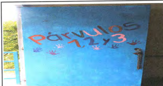
Foto 3: SISTITUCION DE PUERTA DE METAL EN EL AULA DE PÁRVULOS
