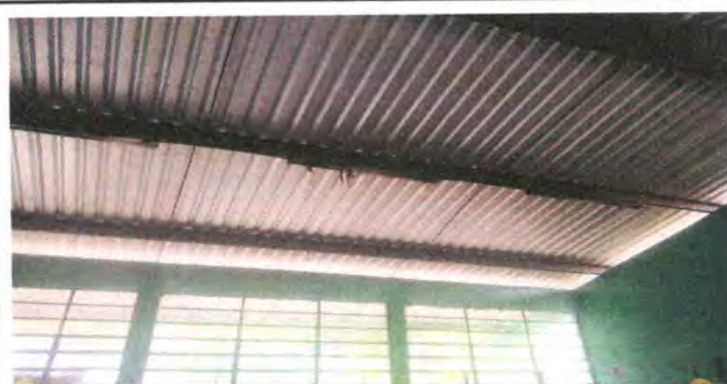
Foto 2: REPARACION DE CABLEADO ELECTRICO EN TRES AULAS.
