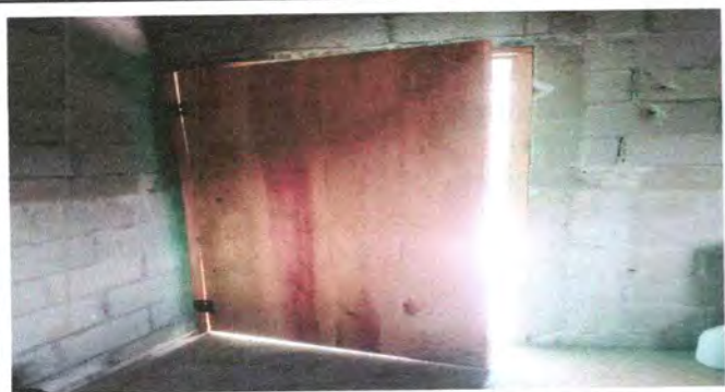
Foto 3: SUSTITUCION DE PUERTA DE MADERA DE LA COCINA POR PUERTA DE METAL.
