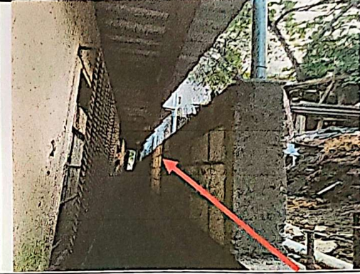
Foto 4: Reparación de muro perimetral de block con tubo hg y malla galvanizada
