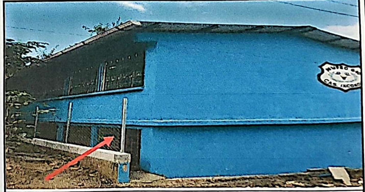
Foto 6: Reparación de muro perimetral de block con tubo hg y malla galvanizada
