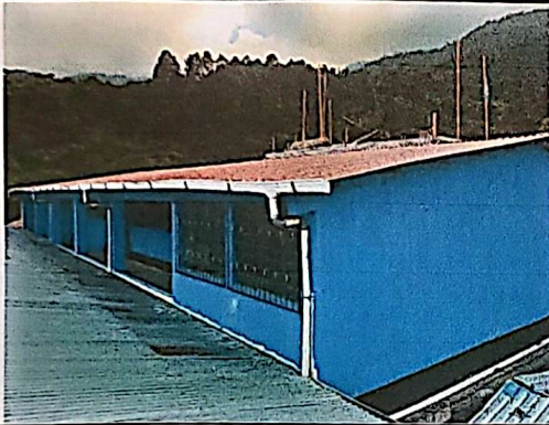
Foto No.3 Pintura en muros exteriores e interiores
