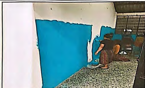
Foto1: aplicación de pintura en interiores de las aulas
