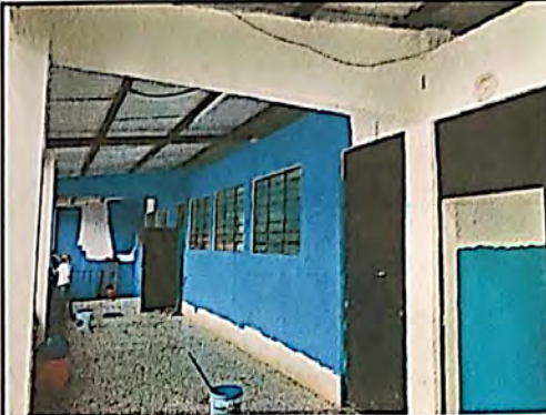
Foto 2: aplicación de pintura en exteriores
