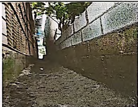
foto 3. reparacion de muros
