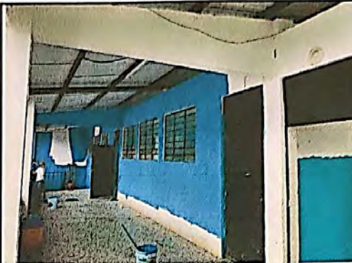
Foto 2: aplicación de pintura en exteriores
