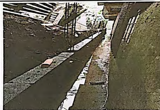
Foto 4: reparacion de muro perimetral
