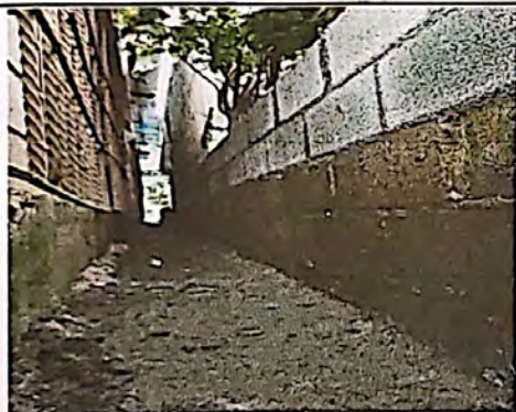
foto 3. reparacion de muros
