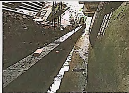
Foto 4: reparacion de muro perimetral
