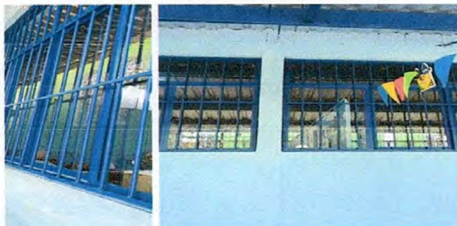
Sustitución de estructura de metal de ventana
