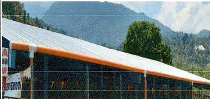
Sustitución de Lamina con capote troquelada de aluzin
