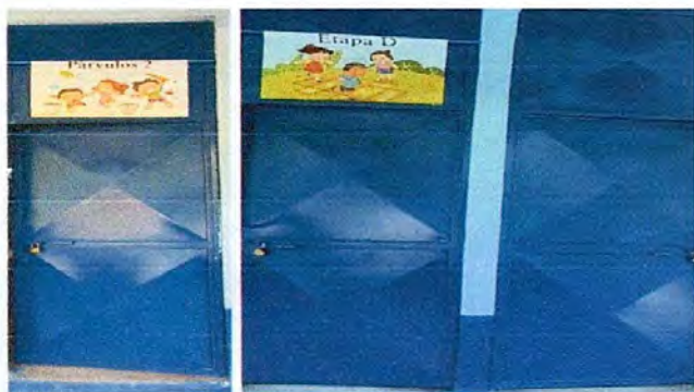
Mantenimiento a puertas de metal
