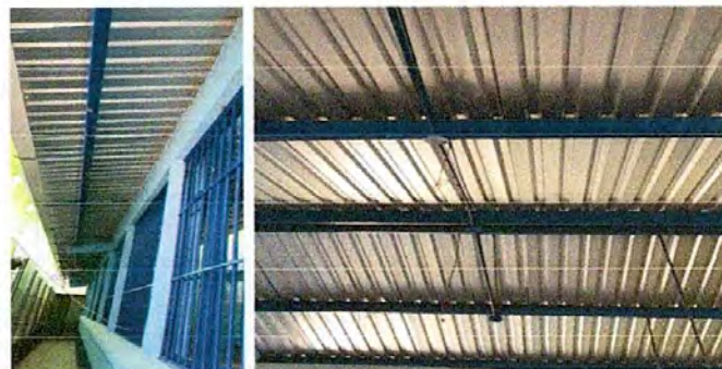
Mantenimiento a estructura de soporte de metal
